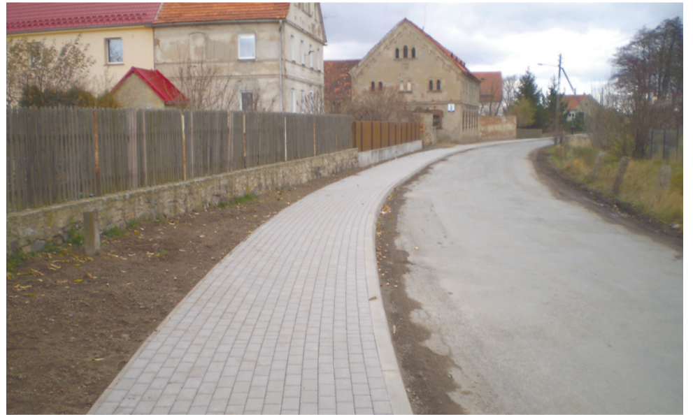
Podniesiono poziom bezpieczeństwa i estetyki wsi poprzez budowę chodników w Piotrowicach.
