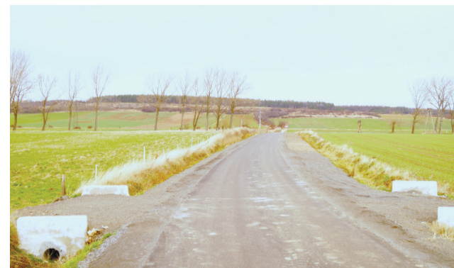
Nowa droga w Męcince zrealizowana została w celu skrócenia dojazdu mieszkańcom do pobliskiego zakładu pracy, jakim jest kopalnia. Inwestycja odciąża również miejscowość z ruchu pojazdów ciężarowych.
