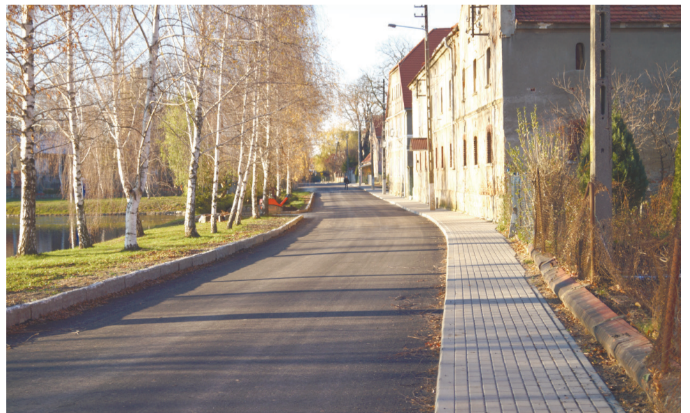
Przebudowana droga wraz z nowym chodnikiem poprawiła standard życia mieszkańcom Matuszowa.
