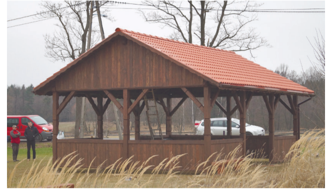
Nowa wiaty rekreacyjna w Muchowie to miejsce, w którym mieszkańcy pracują nad rozwojem swojej Małej Ojczyzny.
