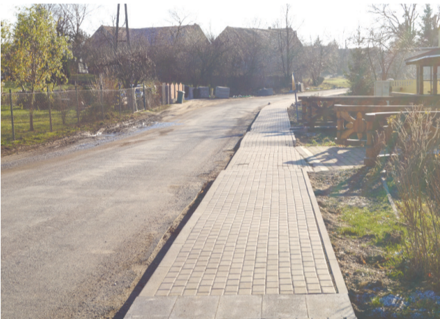
Budowa chodnika przy drodze powiatowej w Piotrowicach.
