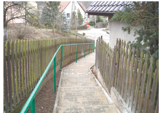
Budowa chodnika w Słupie poprawiła dostęp dla mieszkańców do centrum wsi.
