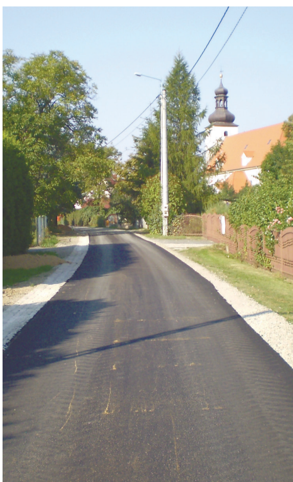
Budowa drogi w Słupie - Mieszkańcom tego sołectwa poprawiony został dostęp do centrum wsi oraz dróg stanowiących komunikację z innymi miejscowościami gminy i powiatu.
