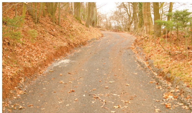
Odbudowane drogi w Kondratowie poprawiły bezpieczeństwo oraz poprawiły standard życia codziennego mieszkańcom obszarów górskich naszej gminy.
