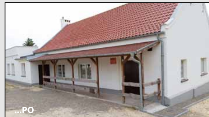
Nowa elewacja świetlicy w Sichówku
