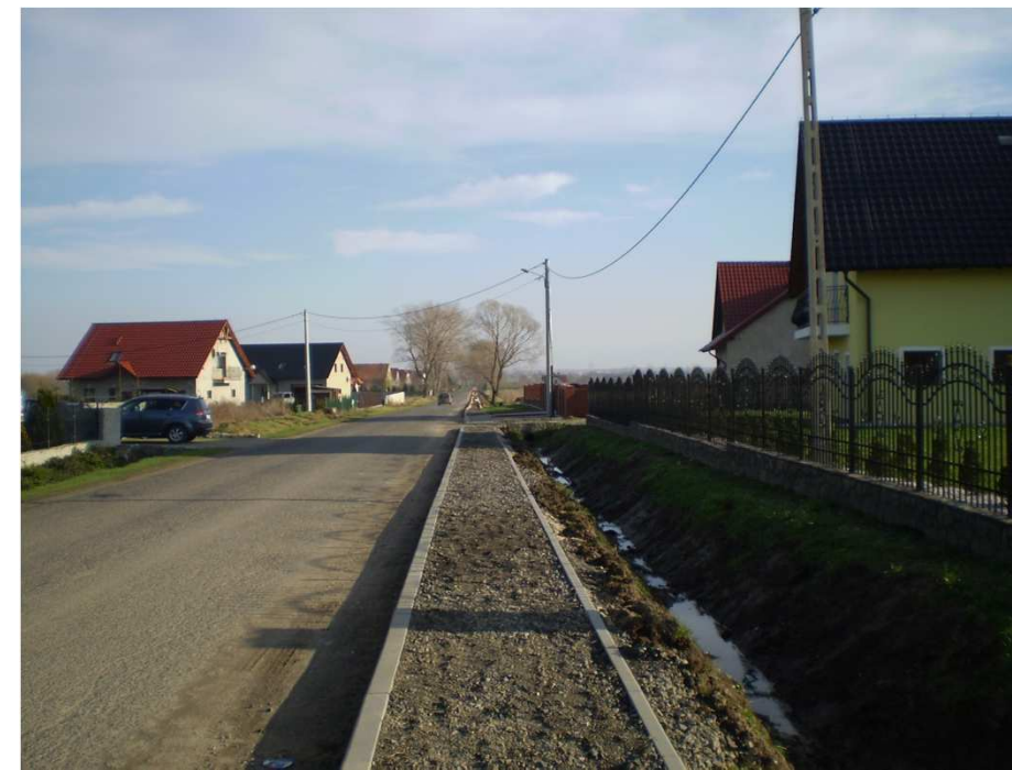
Chodnik w trakcie realizacji.
