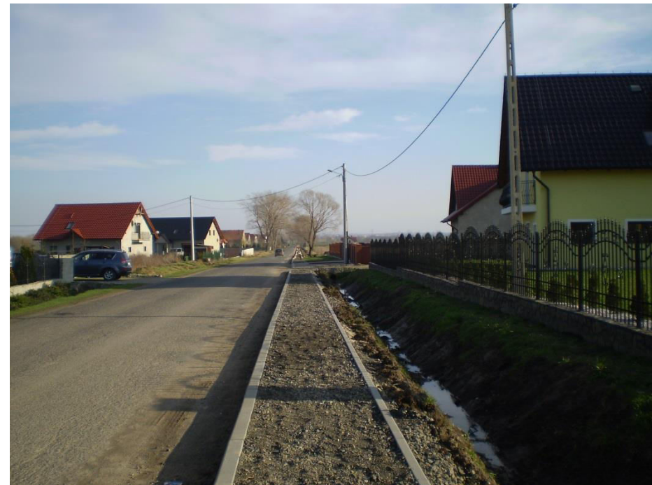
Chodnik w trakcie realizacji.
